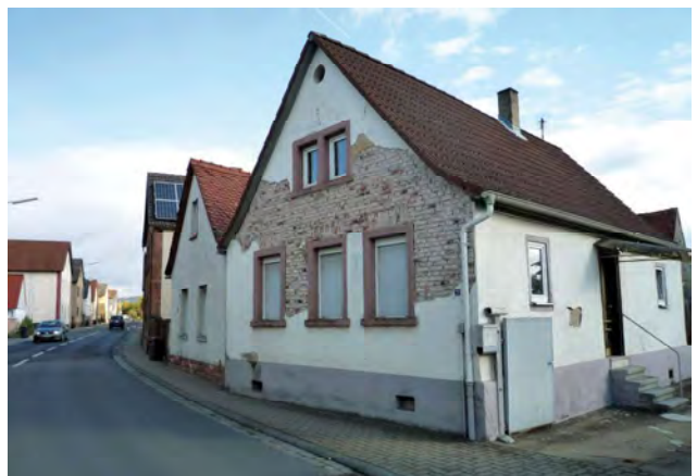
Wohngebäude in schlechtem Bauzustand, Kleinwallstädter Straße
