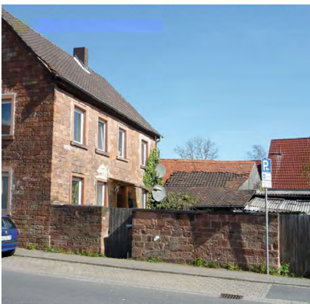
leerstehende Hofstelle in der Bahnhofstraße in schlechtem baulichem Zustand
