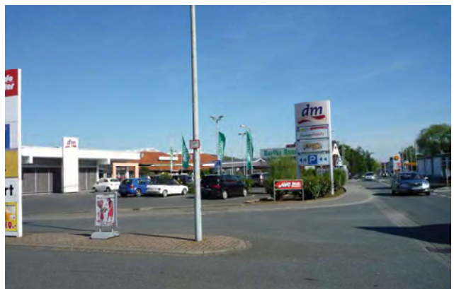
fehlende Raumkante im Märktezentrum in der Erlenbacher Straße
