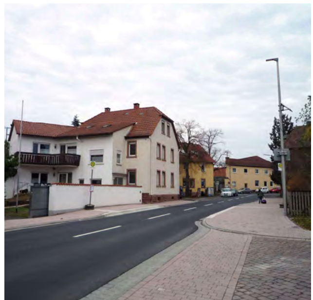
saniertes Abschnitt der Jahnstraße mit barrierefreien Bushaltestellen
