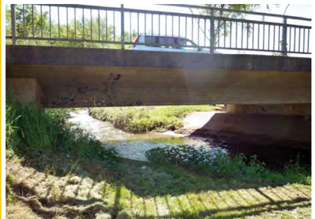
Blick unter die Mainbrücke Marienstraße
