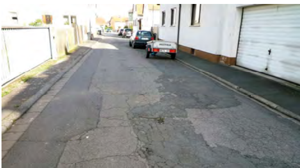
Straßenraum in der Wilhelm-Klug-Straße
