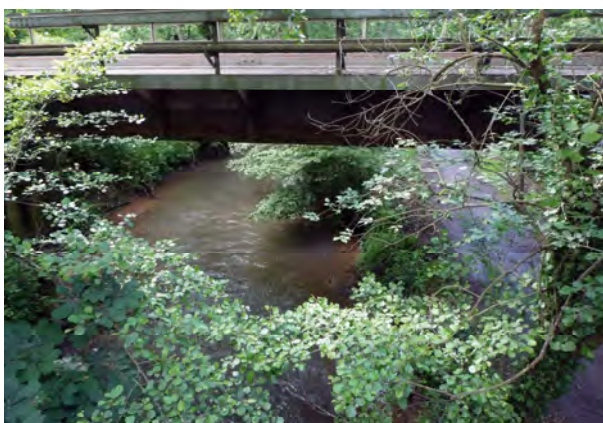
die bestehende Bahnbrücke über die Elsava
