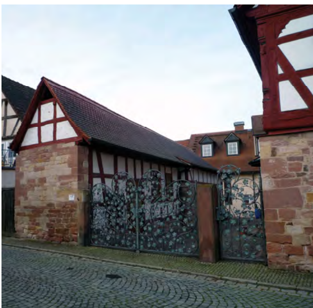
saniertes Anwesen in der nördlichen Hauptstraße
