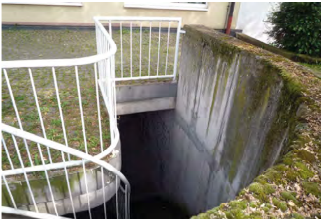
Zugang zur Tiefgarage
