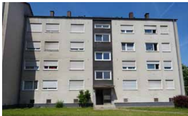
Noch unsanierter Wohnblock in der Elbinger Straße
