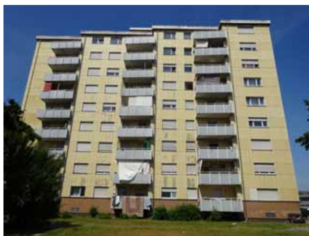
Unsanieretes Hochhaus in der Königsberger Str. 4
