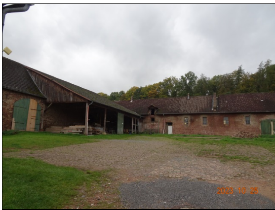
Ehem. Scheune – Kuhstall/Gewölbehalle
