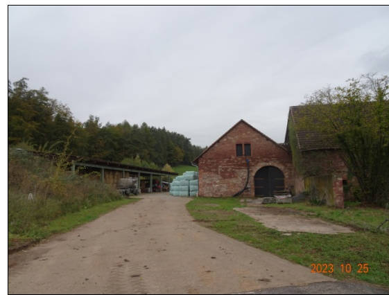
Zufahrt Gewölbehalle und Unterstellhalle
