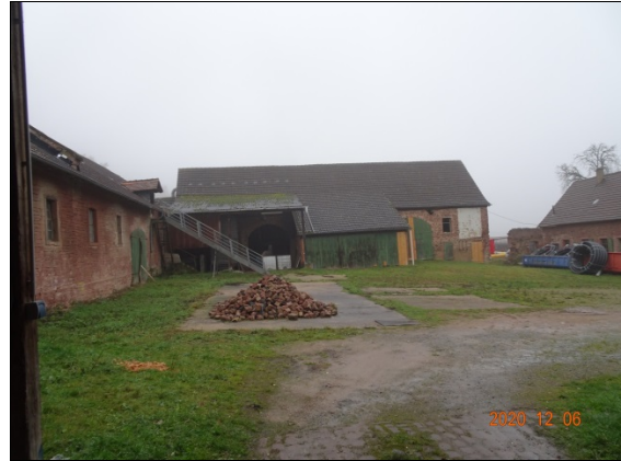
Ehem. Getreidelager- Nordwestflügel
