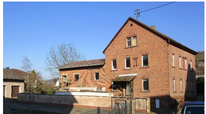
Abb. 11: Bestandsgebäude im Geltungsbereich (Mechenharder Straße 8)
