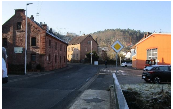
Abb. 1: Sicht auf das Bestandsgebäude bei der Zufahrt über die Elsave-Brücke
