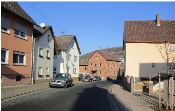
Abb. 10: Benachbarte Wohnbebauung Mechenharder Straße 12, 16 und 18
