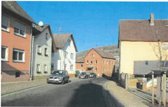
Abb. 10: Benachbarte Wohnbebauung Mechenharder Straße 12, 16 und 18
