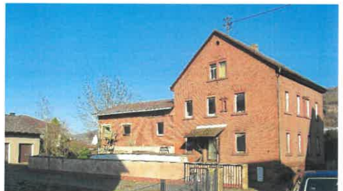
Abb. 11: Bestandsgebäude im Geltungsbereich (Mechenharder Straße 8)
