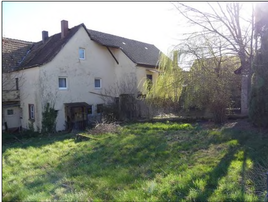
Abb. 3 Bestehendes Gebäude, Rückseite (23.03.2020)
