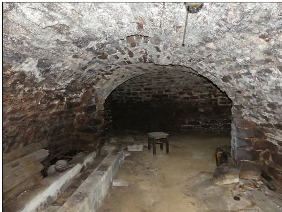
Abb. 12: Gewölbekeller in dem bestehenden Gebäude (28.07.2020)
