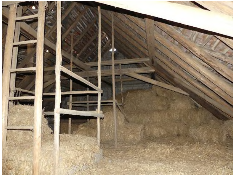
Abb. 11: Strohlager in der Scheune des bestehenden Gebäudes (28.07.2020)
