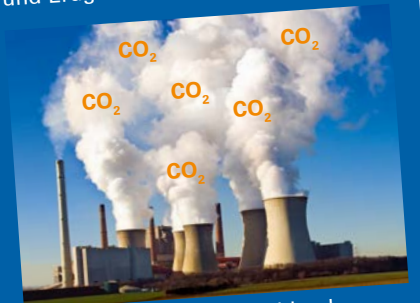
Kohlekraftwerk in Deutschland
