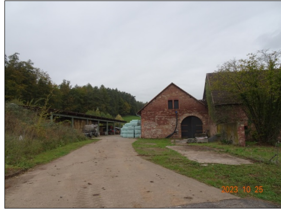
Zufahrt Gewölbehalle und Unterstellhalle
