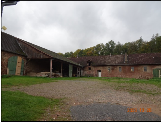
Ehem. Scheune – Kuhstall/Gewölbehalle
