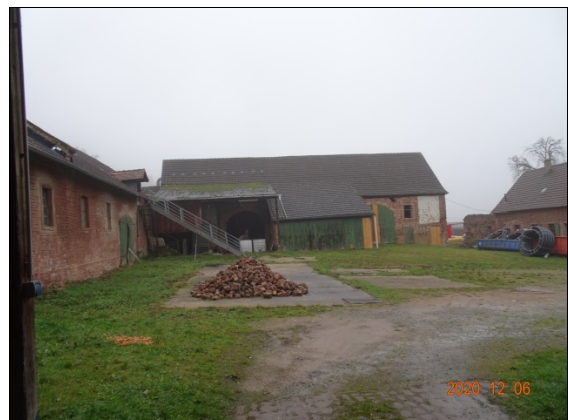
Ehem. Getreidelager- Nordwestflügel
