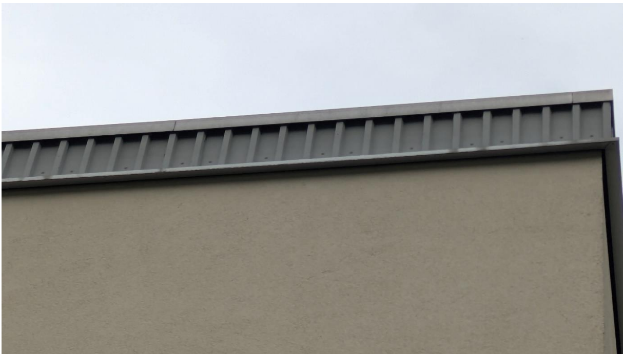
Abb.5: Abgeschlossenen Dachkonstruktion ohne Nutzungshinweise
